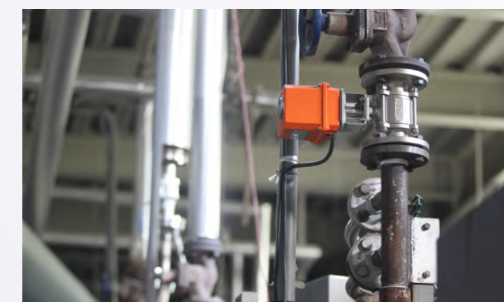
【圖 13】所有輸送蒸氣的管路，都加裝「隔熱裝置」，最大限度地防止熱能散失。同時，在各個節點加裝了精密的自動控制閥，精準控制蒸氣流量，杜絕不必要的逸散。
