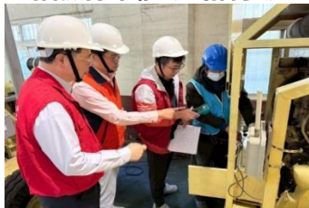
抽檢縣市移動式抽水機
